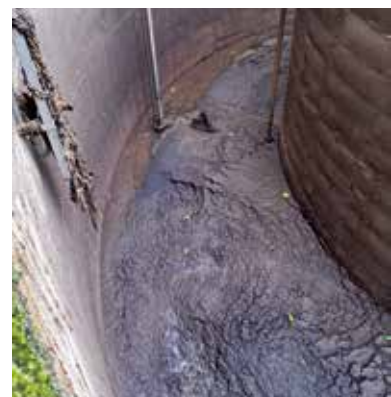
Ablagerungen von Sand und Faserstoffen am Boden des Belebungsbeckens, KW Hubbelrath-Dorf
