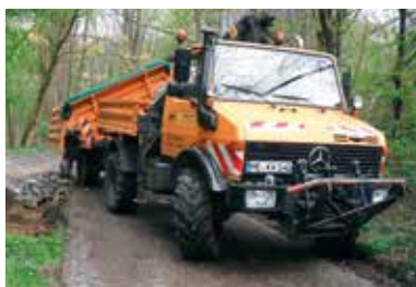
Nebenarbeiten: Für die Abfuhr des Bodenaushubes war eine Ertüchtigung der Zuwegungen erforderlich.
