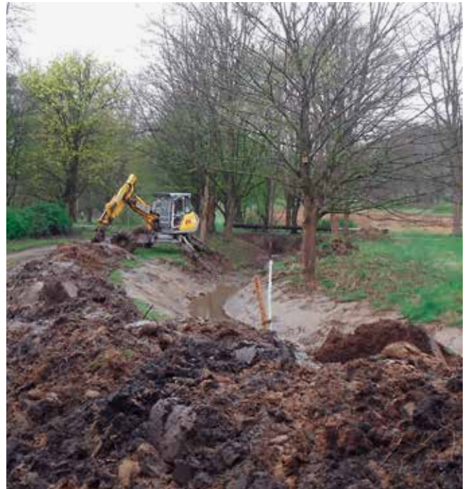
Das geräumte Gewässerprofil mit seitlich gelagertem Aushubmaterial.
