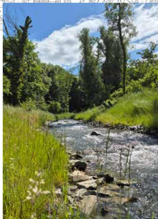
Sohlgleite im Umgehungsgerinne
