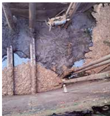
Ablagerungen von Sand und Faserstoffen am Boden des Belebungsbeckens, KW Hubbelrath-Dorf
