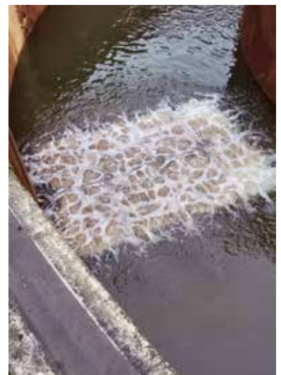
Blasenbild nach Montage, KW Metzhausen
