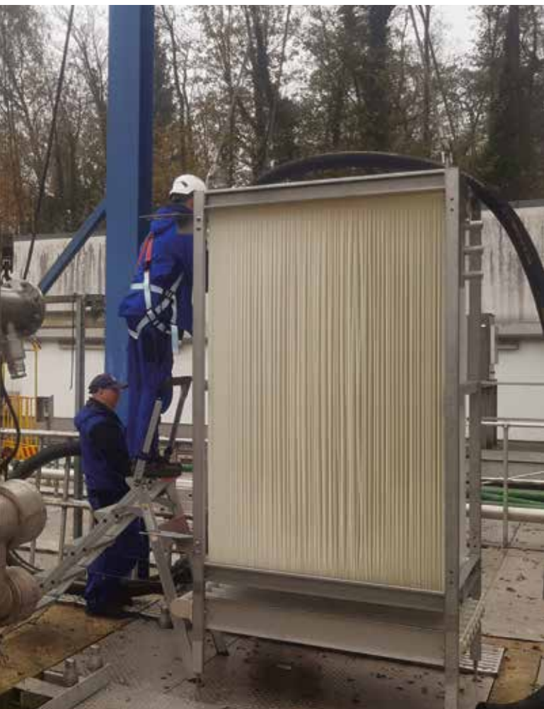
Vorbereitung eines der neuen Membranmodule
