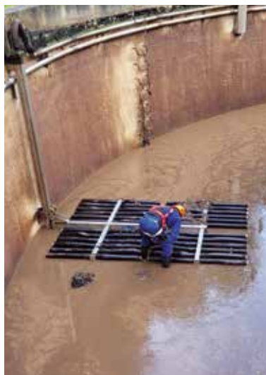
Montage der neuen Belüfterkerzen im Belebungsbecken, KW Metzhausen
