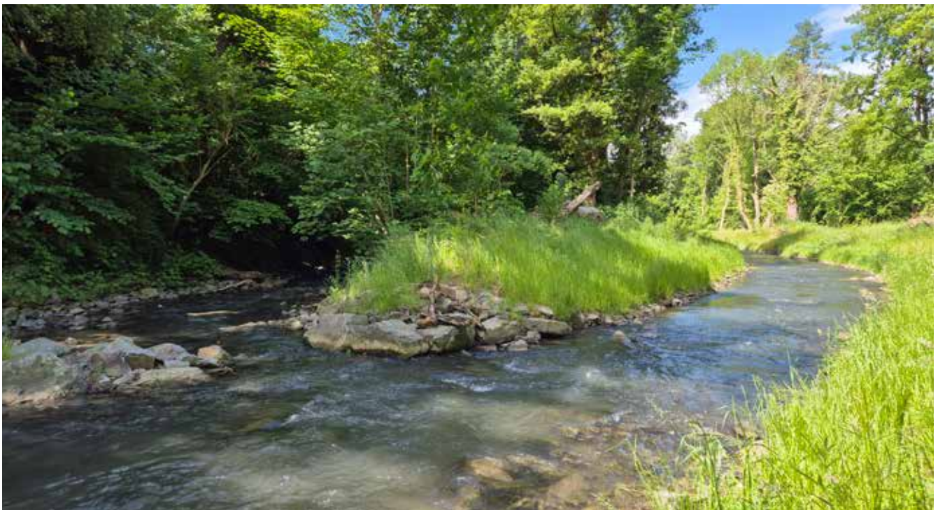
Ein parallel verlaufender zusätzlicher Gewässerlauf (sogenanntes Umgehungsgerinne) im Bild rechts. Blick in Fließrichtung.
