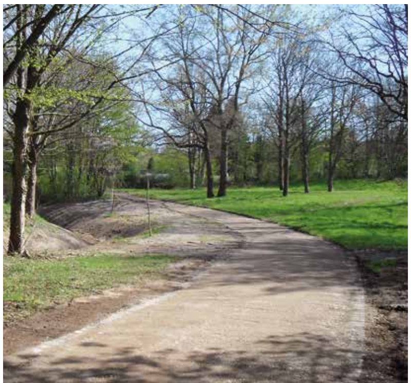
Das Gewässerprofil nach Fertigstellung. Der Aufwand, den eine solche Grundräumung verursacht, ist kaum noch zu erahnen.
